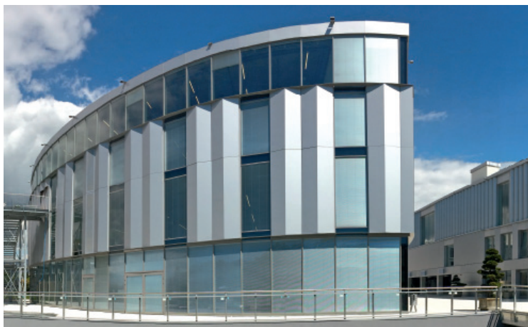
iLife - Etoy, Switzerland / Suisse 900 Jalousien SL29MB mit Integration in KNX-Netz 900 stores SL29MB intégrés au réseau KNX
