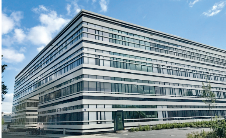
Research Center - Hamburg, Germany / Allemagne 1500 Jalousien SL27MB mit Anbindung an Wetterstation 1500 stores SL27MB intégrés à une station météo
